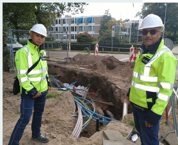
Rakesh (rechts) en Jimmy (links) bij een sleuf met kabels en leidingen langs de Velperweg.
